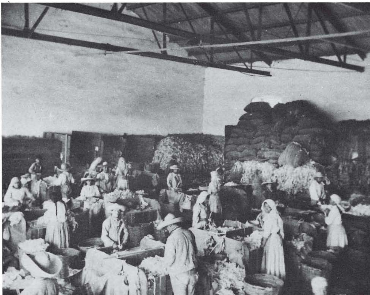
En el trapero laboraban solamente mujeres y niños casi desde los inicios de la fábrica. Cortaban el trapo en pequeñas fracciones, separándolo según su clase, color y estado de limpieza. Una vez escogido, se trituraba y pasaba a los hervidores.
